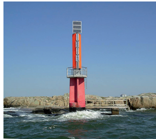
Luces de enfilación Los tubos de luz se pueden usar para mejorar la visibilidad de una línea de enfilación. Instalados verticalmente en los paneles diurnos, las luces de enfilación se vuelven muy conspicuas en áreas donde hay mucha luz de fondo.
